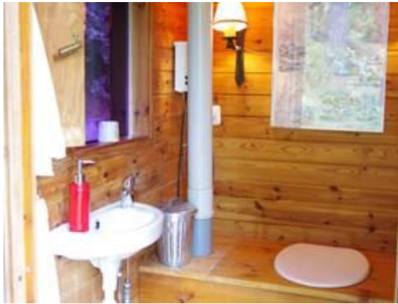
Tvätttrum med TC (Ny frystoa installeras 2011) / TC ( New freezer toilet installed in 2011)
